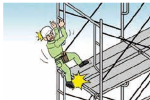
足場組立作業での墜落
