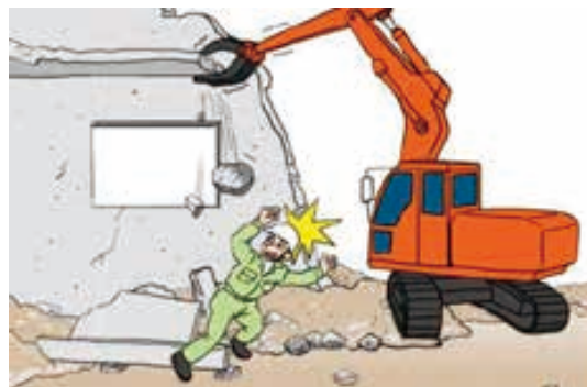
解体作業での飛来・落下
